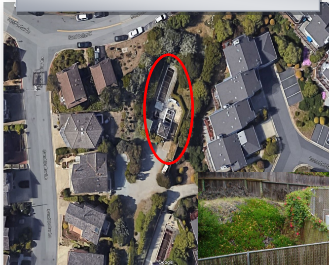
Canon del Sol WWTP & Sand Dollar WWTP
